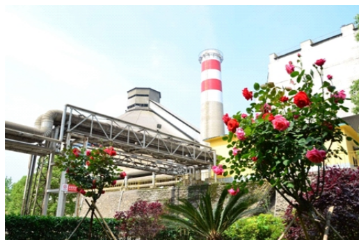
收尘器改造后的阳新公司 Yangxin Plant—after dust collector upgraded
